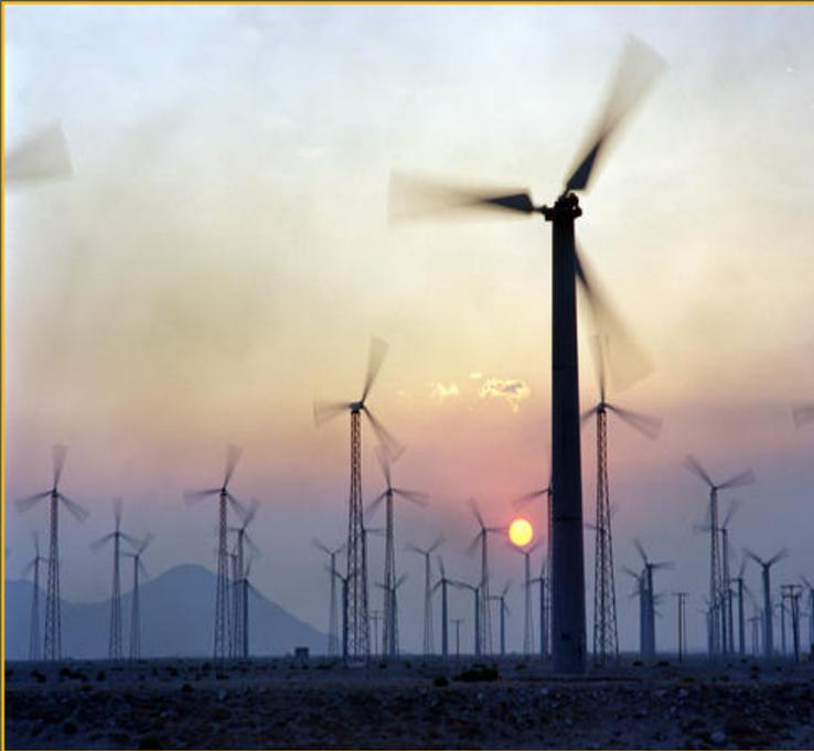
Aerogeneradores tripala de eje horizontal
